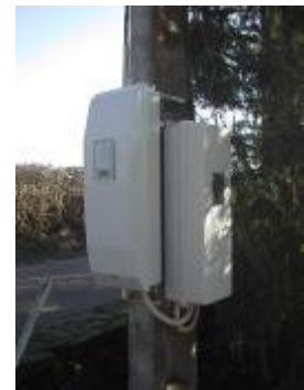
Compteurs de production et de non consommation GAEC de Vernotte à St Pierre de Varennes (71) Source ADEME
